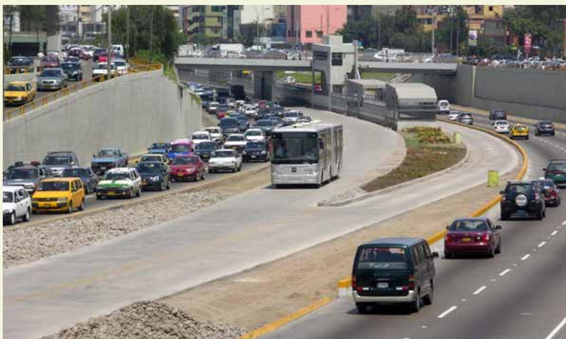
Lima, no Peru, usa concreto armado em toda a extensão da faixa segregada.
